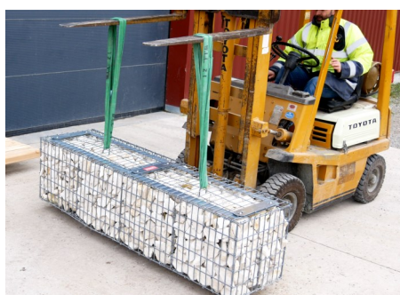
Positionnement du gabion
